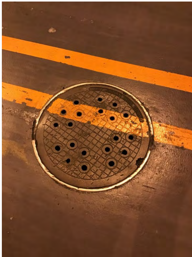
Manhole 8 at H48
