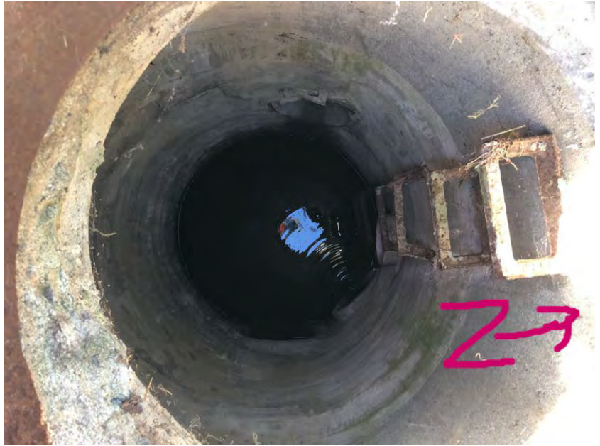
Stark 1E Sidewalk
